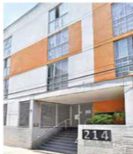
Foto: Especial Fachada del edificio donde se cometió la agresión.
