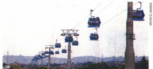
La Línea 1 del Cablebús tiene un sistema de monitoreo del cable las 24 horas del día, destacó la empresa operadora Doppelmayr.
