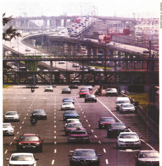
El proyecto consistía en un viaducto elevado sobre Calzada Ignacio Zaragoza de 12.7 kilómetros. Las autoridades analizan si lanzan otra convocatoria, pero no hay fecha.
