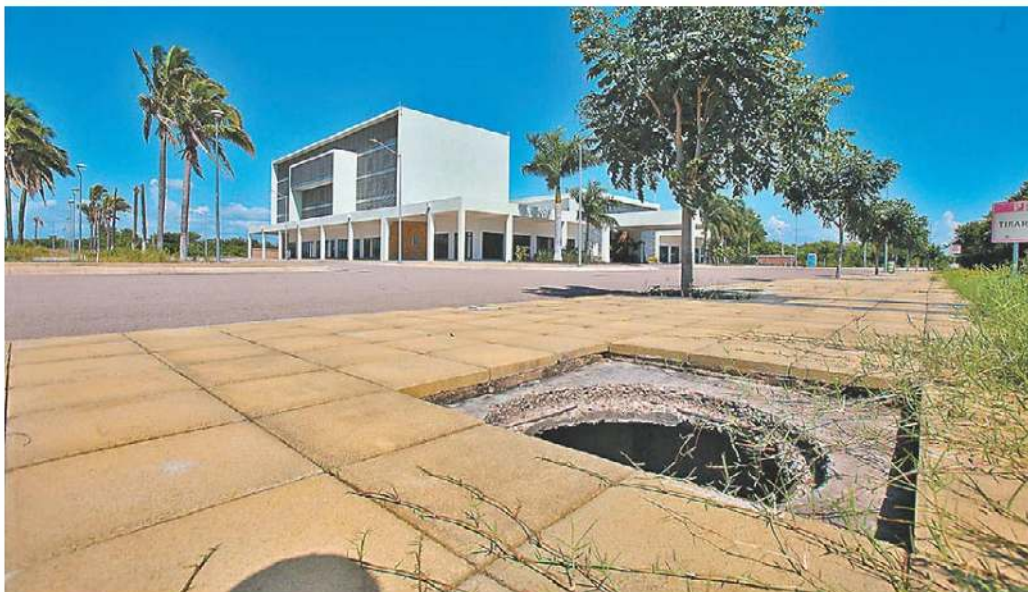
El megaproyecto iba a contar con viviendas y canales para la navegación. JUAN CARLOS BAUTISTA
