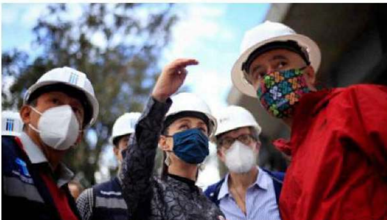
La jefa del GCDMX, Claudia Sheinbaum Pardo, realizó una visita de supervisión a las obras de construcción del Trolebús Elevado Eje 8 Sur.
