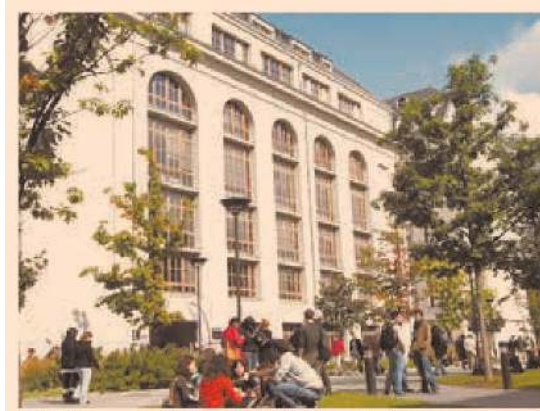
Edificio sede del Instituto Confucio en París. FOTO: ESPECIAL
