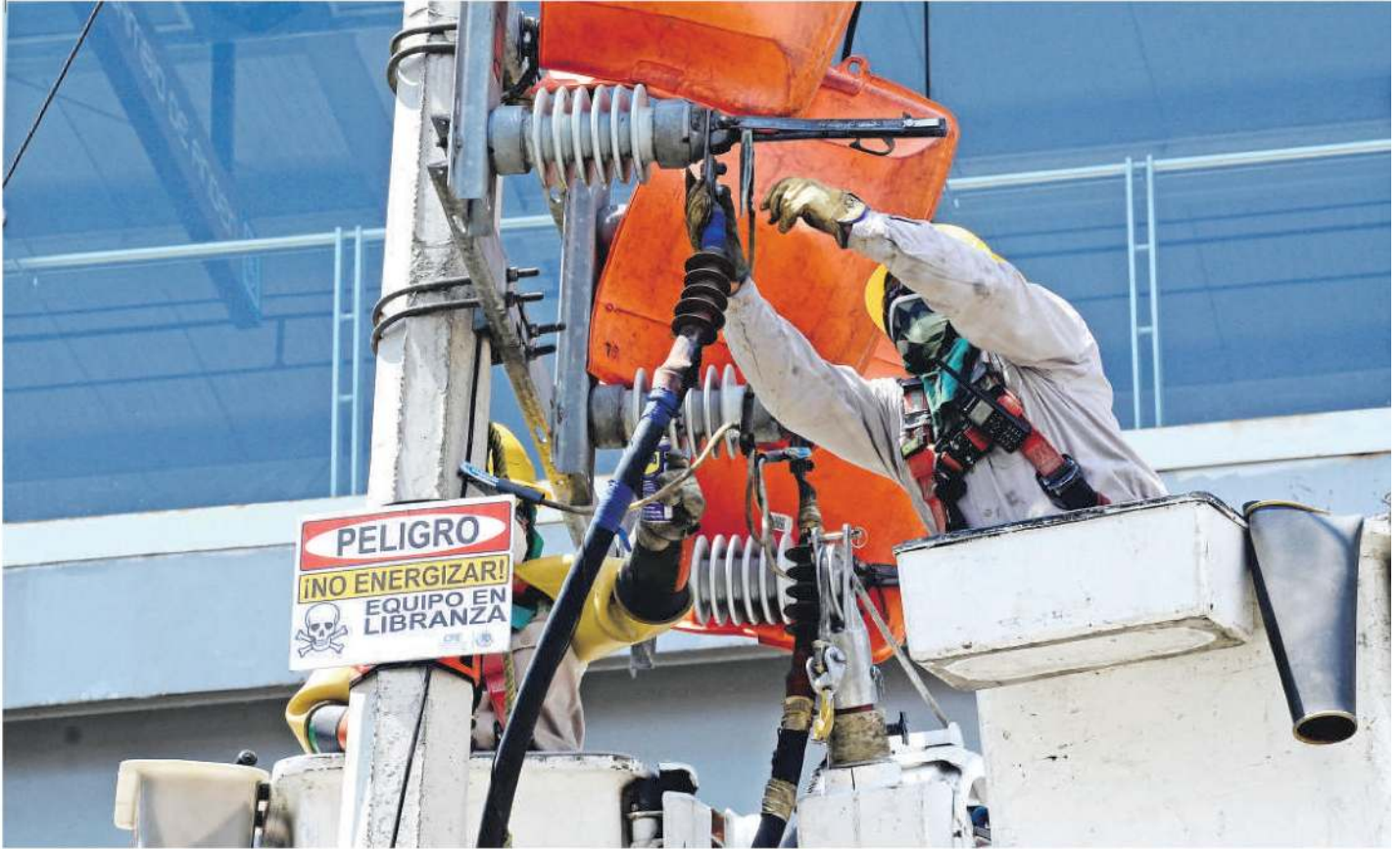
Personal de la CFE revisa el cableado de las líneas de alta tensión en avenida Tláhuac, en la Ciudad de México
