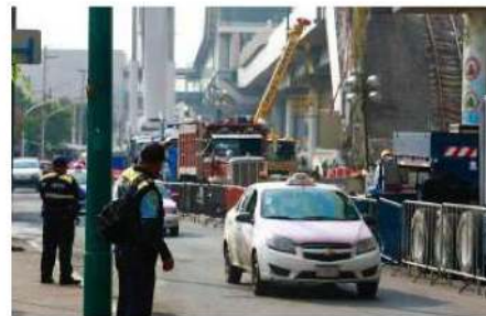
El pasado 3 de mayo la Línea 12 del Metro colapsó. Cuartoscuro
