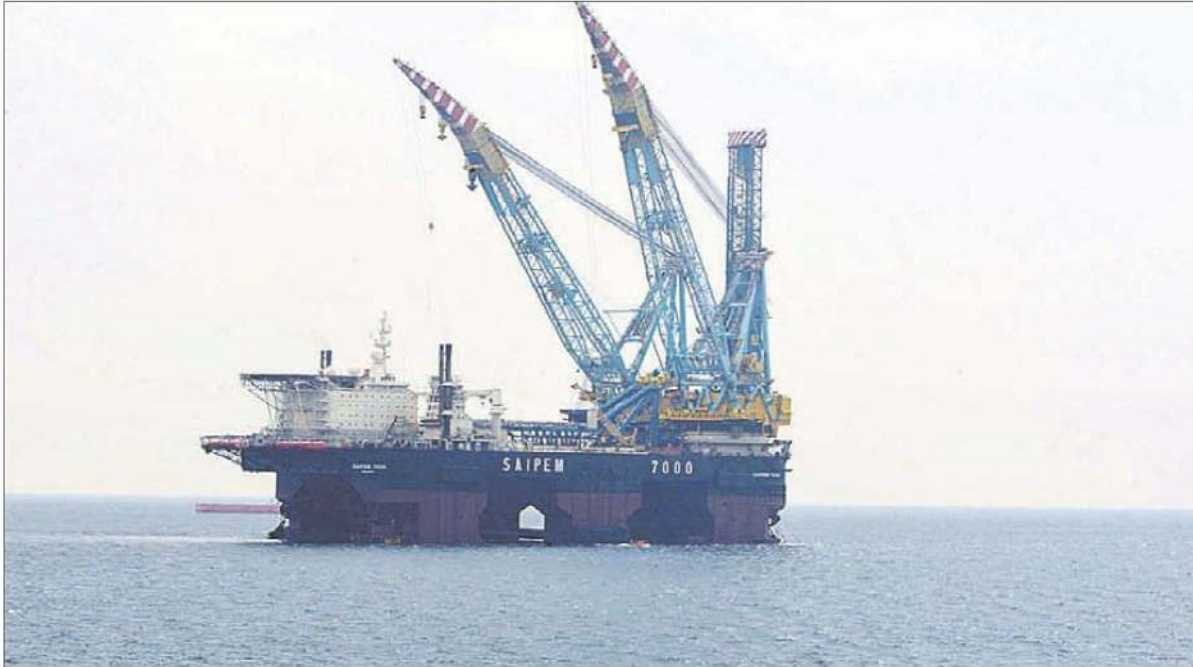
Plataforma de Medgaz situada frente a la costa almeriense, que construye el gasoducto entre España y Argelia. EFE
