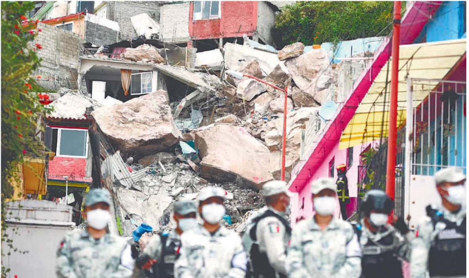
El Gobierno mexicano realiza un censo de viviendas dañadas en el lugar del derrumbe ocurrido el 10 de septiembre
