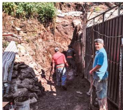
MEDIDAS. En la casa de los Fernández todavía se encuentran retirando escombros y se allistan para colocar una barda de contención para evitar la mancha urbana.
