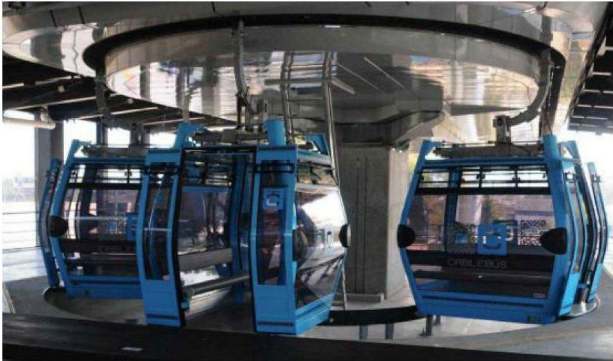
Leitner será sancionada por las fallas que presentó el Cablebús tras el sismo del pasado 7 de septiembre.
