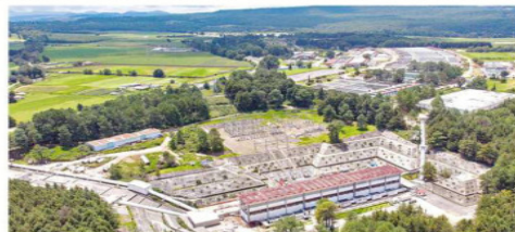
Después de su planta potabilizadora, el sistema Cutzamala sólo tiene una línea de conducción del agua hacia la metrópoli.
