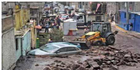
Cuatro casas y siete vehículos sufrieron daños de manera directa por el deslave de la Sierra de Guadalupe.
