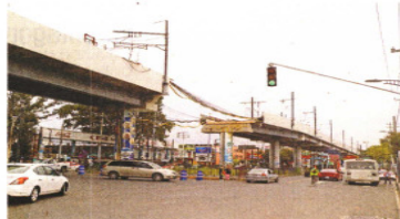
Serán 250 tramos los que tendrán reforzamiento y se espera que las obras terminen en 12 meses.
