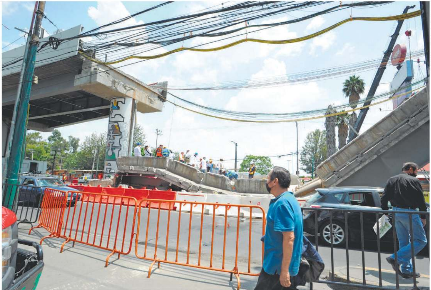
En breve comenzará la rehabilitación de la zona elevada de la L12
