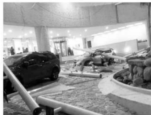
En Guerrero hubo caída de estructuras
