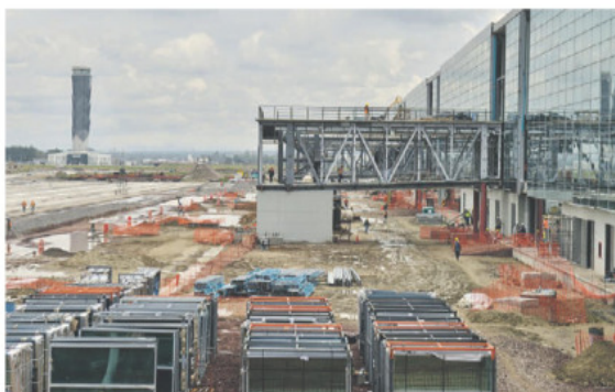
PARA 2022. El aeropuerto 'Felipe Ángeles' tiene un avance de 70 por ciento de obra.
