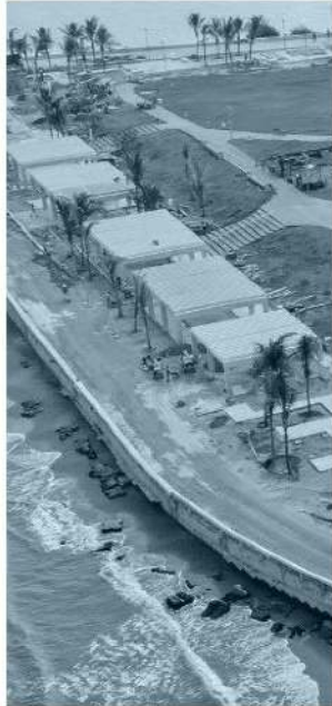
Mejoramiento Urbano / Sedatu
