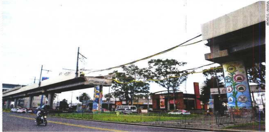
Las obras tardarán 12 meses y no se precisó la fecha de reapertura de la Línea 12 del Metro.
