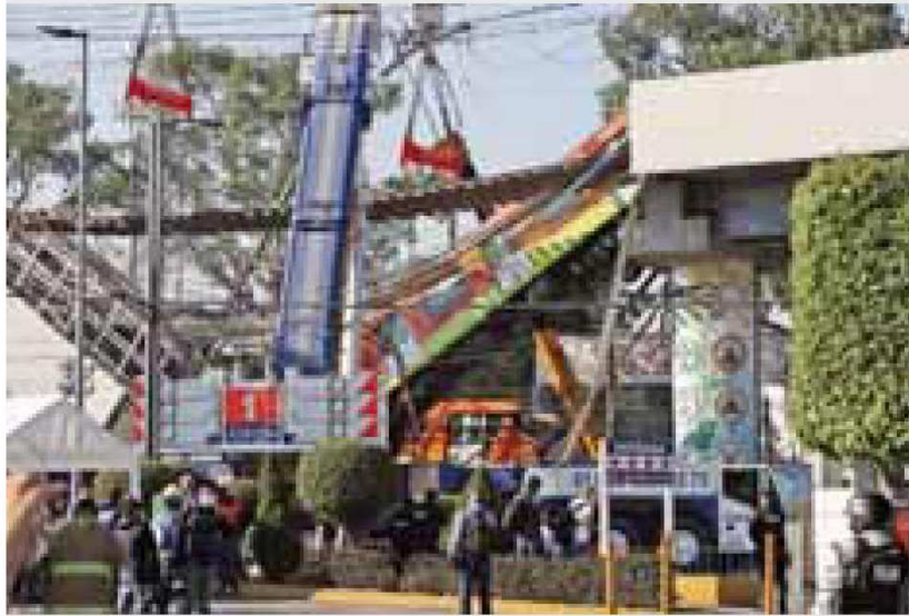
El tramo colapsado será reconstruido en su totalidad. / NICOLÁS CORTE
