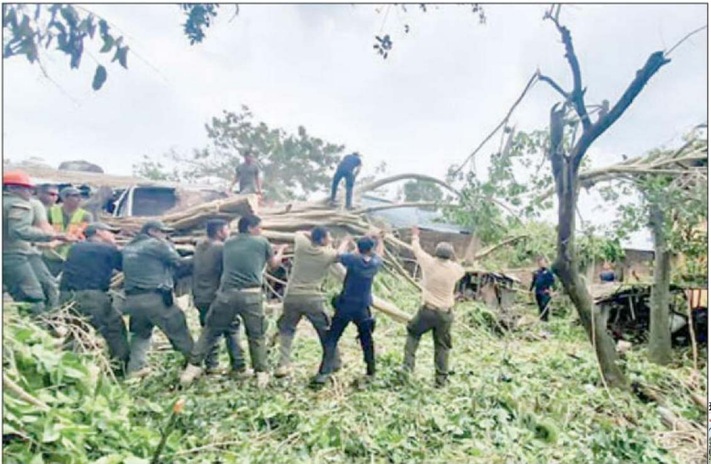
▲ Brigadas de Protección Civil de Veracruz retiran escombros en los municipios más afectados por el huracán Grace el pasado fin de semana, entre ellos Tecolutla (imagen), Papantla, Tuxpan, Poza Rica,
