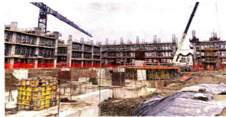
Avance de las obras en Dos Bocas hasta el 21 de agosto.
