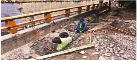
Las obras deberán concluir a finales de este mes.
