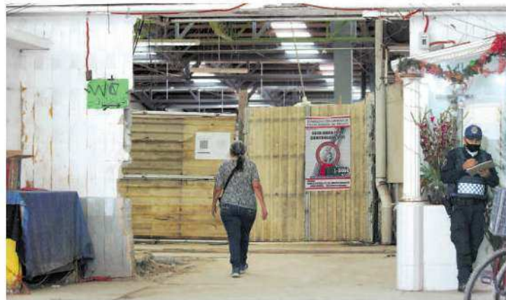
San Cosme , dañado por un incendio, se reactivará en diciembre
