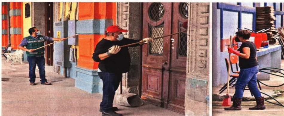
MANITA DE GATO. En la Escuela Secundaria Diurna N°1 "César A. Ruiz" se realizan labores de remodelación.
