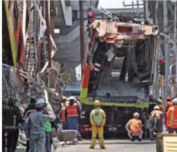
Reapertura. La jefa de Gobierno, Claudia Sheinbaum, resaltó avances en la rehabilitación de la Línea 12. / NICOLÁS CORTE
