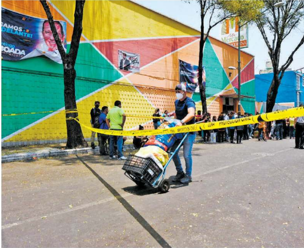
La Moderna vio en abril cómo su techo colapsó, ahora recibirá 25 millones de pesos
