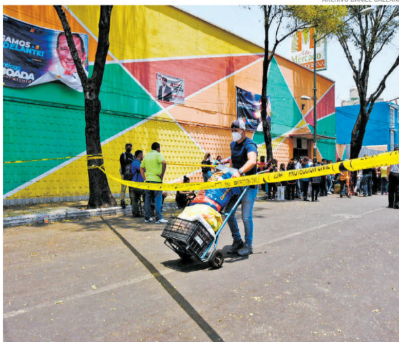
La Moderna vio en abril cómo su techo colapsó, ahora recibirá 25 millones de pesos
