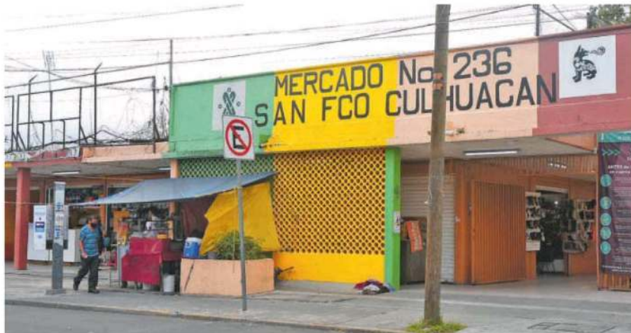
En 2022 terminarán de hacer las correcciones en materia de instalación eléctrica en los 335 mercados públicos capitalinos /JOSÉ MELTON
