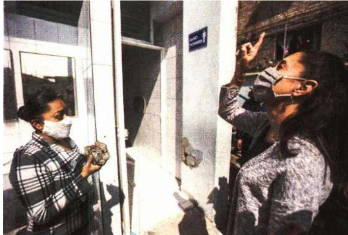
La jefa de Gobierno acudió ayer a la primaria Dr. Conrado Menéndez a verificar el estado del inmueble.
