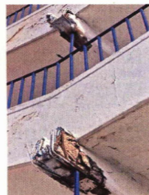
Los padres de familia acusaron que el plantel presenta varillas expuestas y fisuras.
