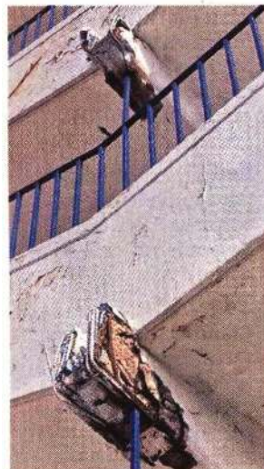
■ Los padres de familia acusaron que el plantel presenta varillas expuestas y fisuras.
