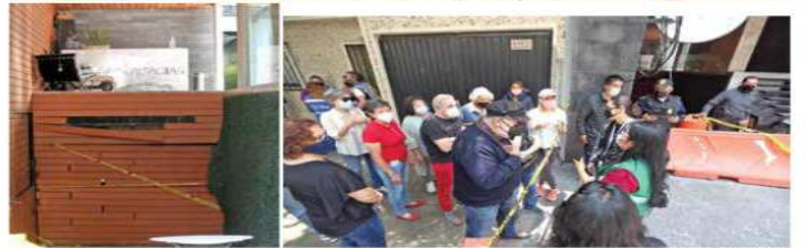
Fotos: David Solís El edificio tiene resguardo de la policía capitalina (arriba); de acuerdo con el peritaje, los daños llegaron hasta la recepción (abajo izq.); inquilinos trataron de volver a entrar, pero personal de la jefatura de gobierno les indicó que ya nadie tenía autorización de entrar al inmueble (abajo der).
