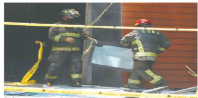
Elementos de Protección Civil y bomberos retiraron todos los vidrios de la zona afectada.
