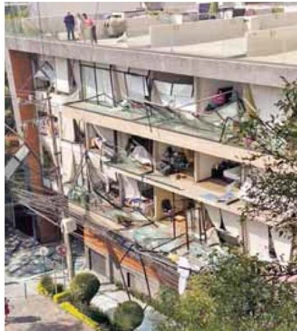
Afectaciones. Tuvieron que ser desalojadas 300 personas de inmuebles aledaños. / CUARTOSCURO
