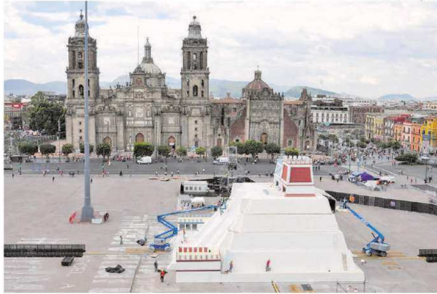
Está construida con tramas de metal y recubierta con triplay
