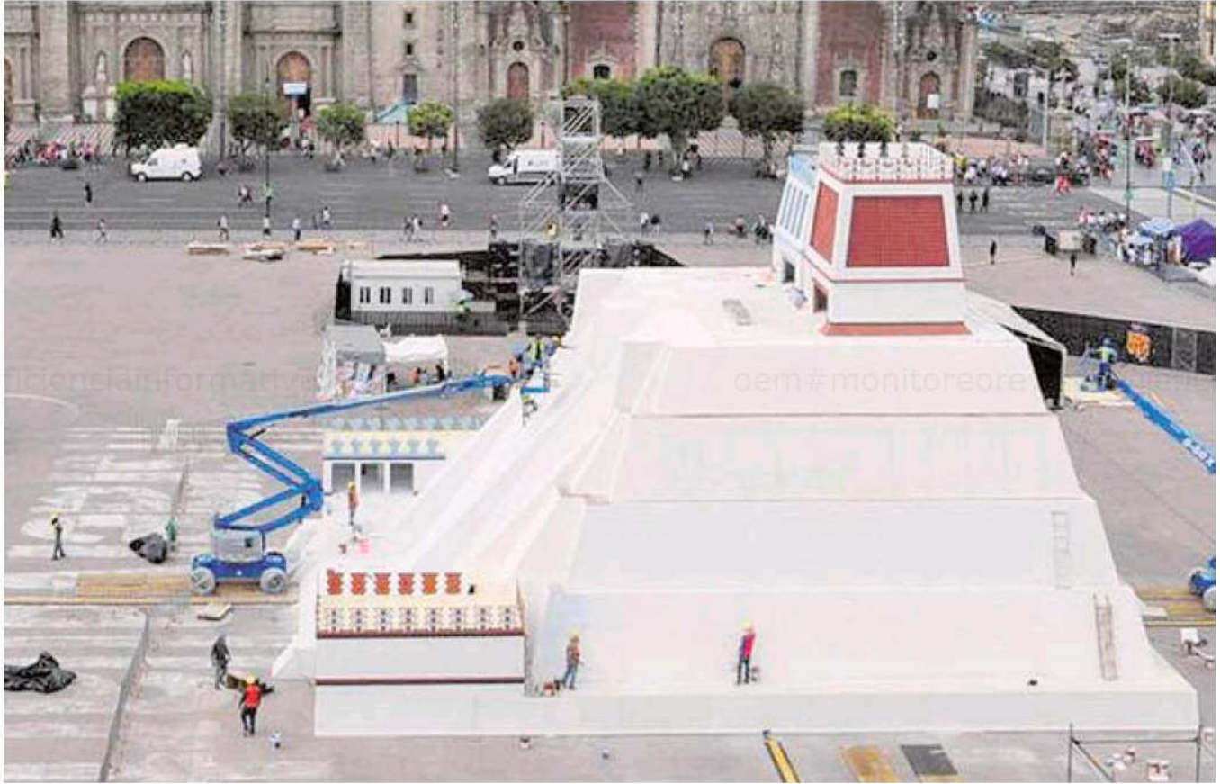
Está construida con tramas de metal y recubierta con triplay
