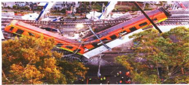
La investigación de los peritos de la FGJ se basa en el dictamen preliminar de la empresa DNV, que indica que el error fue por una mala supervisión de la obra.
