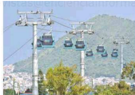
A lo largo de la ruta del Cablebús se trabaja en la intervención social y urbana de un total de 5 kilómetros /DAVID DEOLARTE
