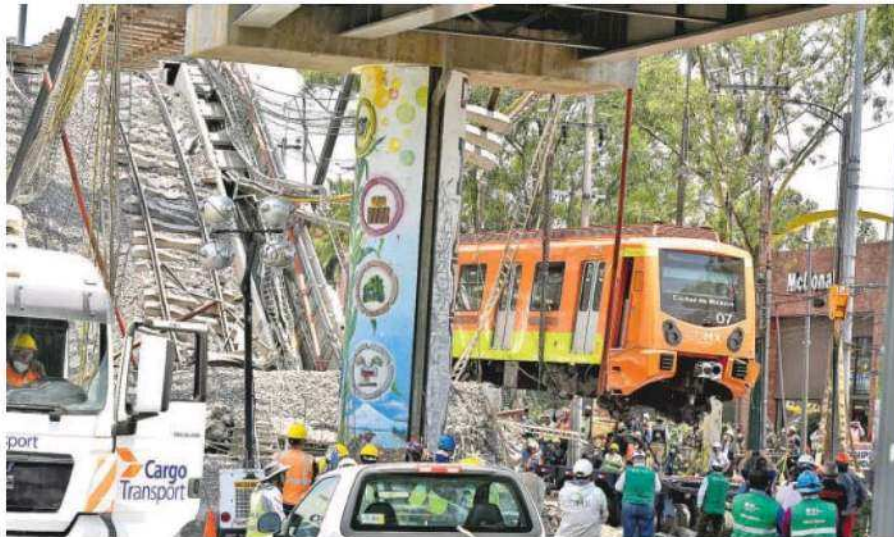
Hoy se cumplen tres meses del desplome de la Línea 12 del Sistema del Transporte Colectivo Metro /DAVID DEOLARTE
