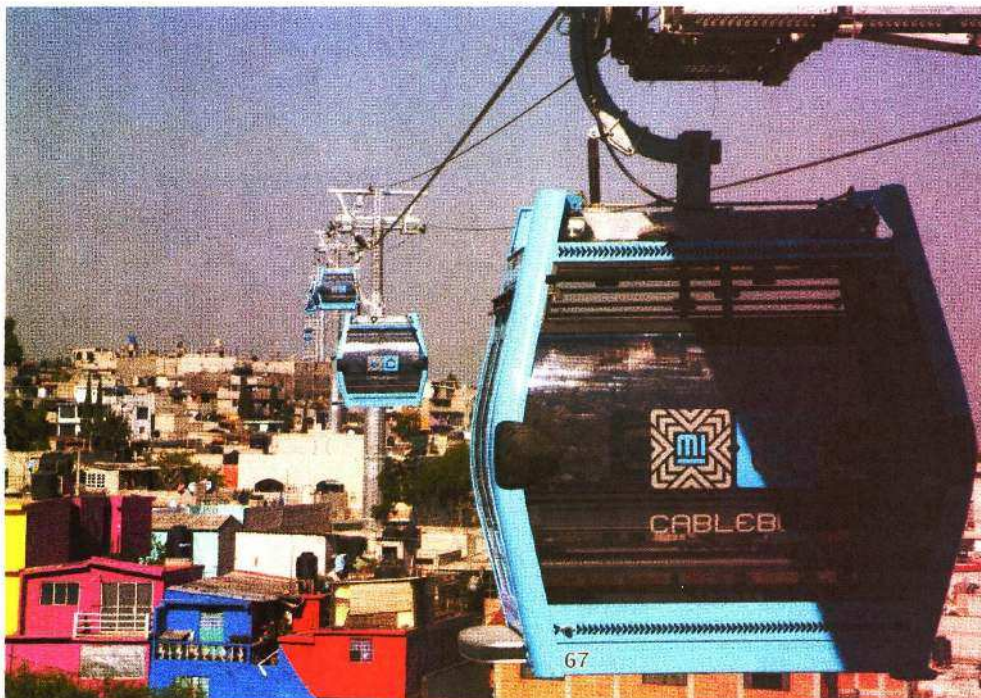
La Línea 2 del Cablebús fue construida con una inversión de 3 mil 183 millones de pesos y recorrerá 10.6 kilómetros, desde Constitución de 1917 a Santa Martha, en la alcaldía Iztapalapa.
