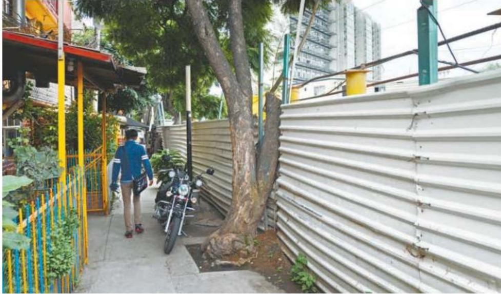
Los trabajos para ampliar la L12 continúan
