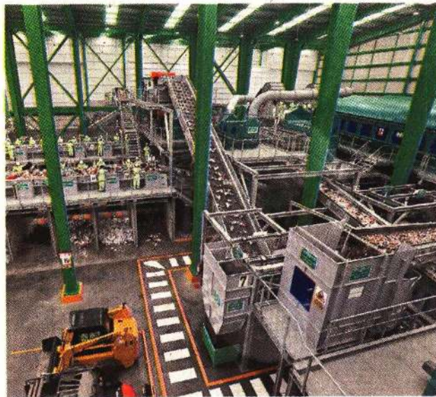
La nueva planta de tratamiento se localiza en Azcapotzalco.
