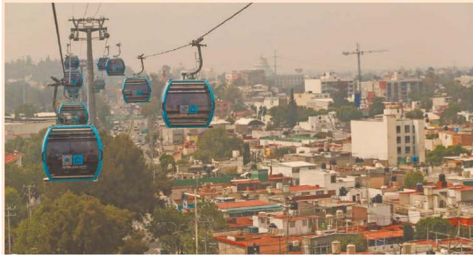
El teleférico cuenta con una longitud de 9.2 kilómetros a lo largo de 63 antenas y seis estaciones. FOTO: REUTERS
