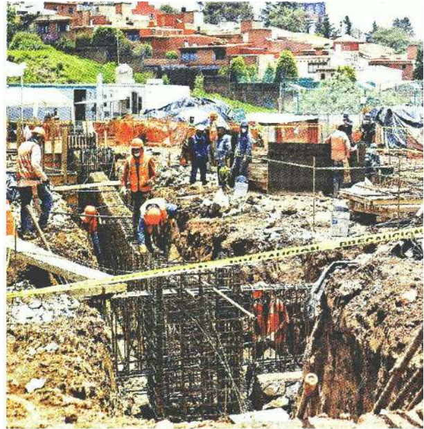
La Jefa de Gobierno, Claudia Sheinbaum, asistió a la obra donde construyen el Hospital General de Cuajimalpa.
