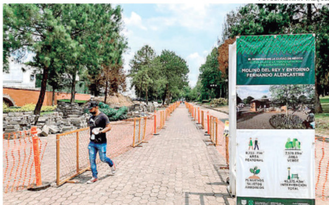
En Los Pinos ya comenzaron a realizarse las modificaciones al terreno
