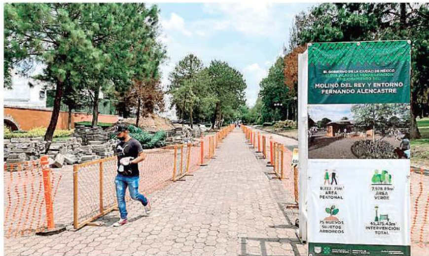
En Los Pinos ya comenzaron a realizarse las modificaciones al terreno
