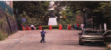
Las obras serán realizadas por la empresa Fredel, con una inversión de 186 millones de pesos.
