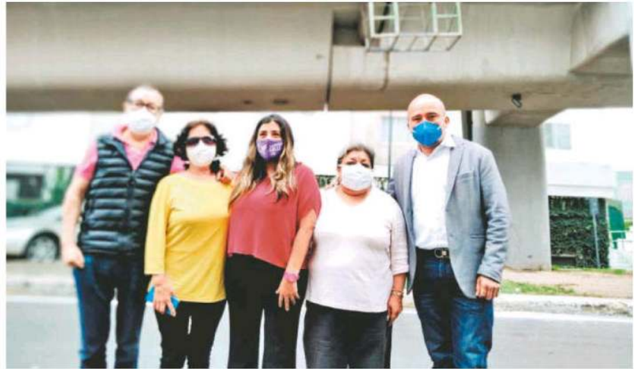
Constatan diputados locales del PAN que el puente Muyuguarda está en riesgo de sufrir un colapso /FOTO: CORTESÍA
