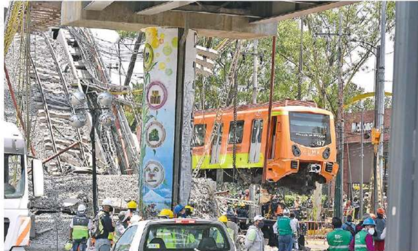
Colapso de la Línea 12 del Metro; ninguna familia ni persona quedará en desamparo, asegura el gobierno capitalino /FOTO: DAVID DEOLARTE
