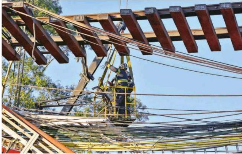
Este mismo mes darán a conocer toda la rehabilitación que se va a llevar a cabo en la Línea 12 del Metro /FOTO: DAVID DEOLARTE
