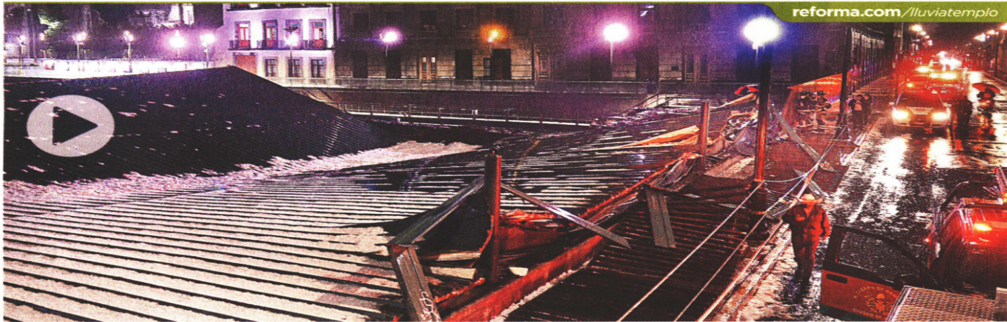
NADIE LO VIO VENIR. La granizada fue tan fuerte que ocasionó la caída de la cubierta de la Casa de las Águilas, en el Templo Mayor. La Secretaría de Cultura señaló que no hubo daños graves.
