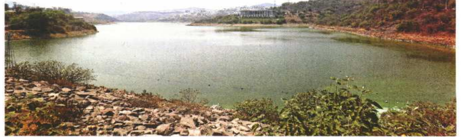
La Presa Madín, que abastece a los habitantes de Naucalpan, Atizapán y Tlalnepantla, está a 75% de su capacidad. Se eliminarán las descargas de aguas negras para que no contamine el líquido que se va a potabilizar.
