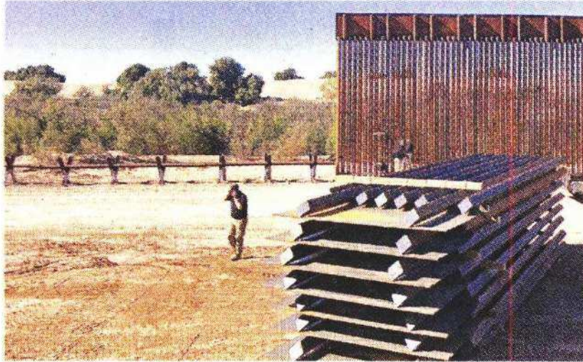
■ Parte de la valla vieja del muro fue reemplazada en los últimos días de Trump, pero las obras no se terminaron.
