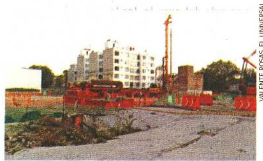
Actualmente, en la capital están autorizadas 76 megaobras, aunque sólo están activas 31.
