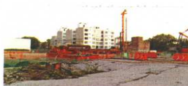
Actualmente, en la capital están autorizadas 76 megaobras, aunque sólo están activas 31.
