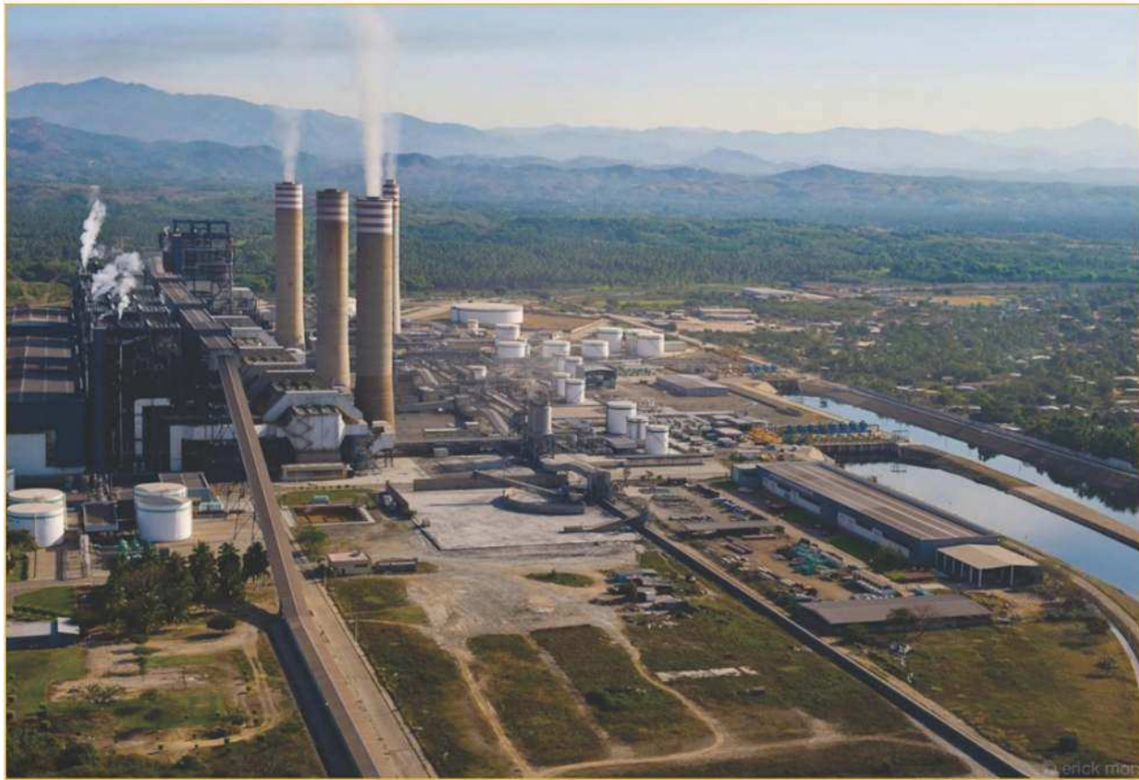
De acuerdo con la Comisión para la Cooperación Ambiental de México, Estados Unidos y Canadá, la central carboeléctrica de Petacalco, Guerrero, es la principal generadora de CO 2 de todas las centrales eléctricas del país con 15 millones 163 mil 296 toneladas al año. También es la principal generadora de mercurio con 710.97 toneladas al año Foto tomada de Twitter
