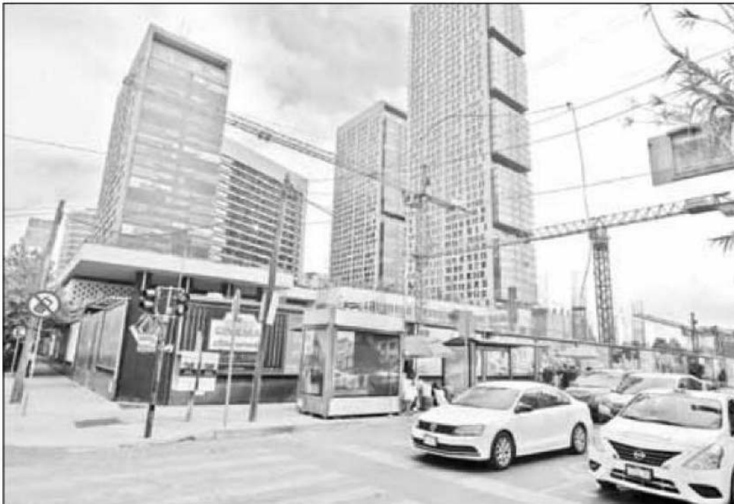
► Vista del predio de Ejército Nacional 769, colonia Granada (Miyana), en Miguel Hidalgo, donde el Congreso local avaló el cambio de uso de suelo para construir un hotel. Foto Cristina Rodríguez
