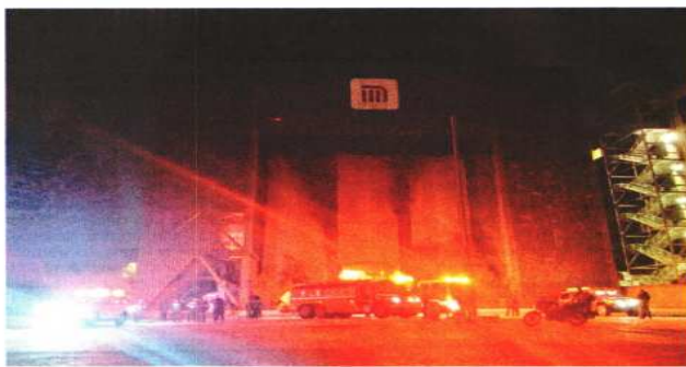
La madrugada del sábado 9 de enero se reportó un incendio en el sótano de Delicias 67, Centro, lugar donde están las oficinas centrales del Metro.
