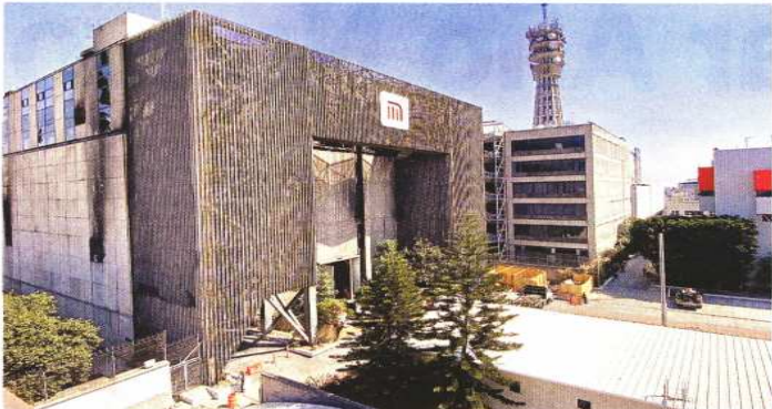
En las oficinas de Delicias 67 se registró el incendio que dejó fuera de funcionamiento 6 de las 12 Líneas del Metro.
