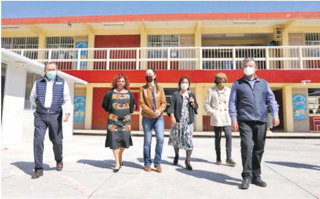
Quedarán rehabilitadas este año las 776 escuelas públicas que resultaron dañadas durante el sismo de 2017 /FOTO: CORTESÍA GCDMX
