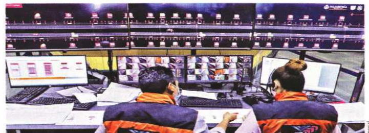
La Línea 1 operará desde el Puesto de Control emergente luego del incendio del 9 de enero.
