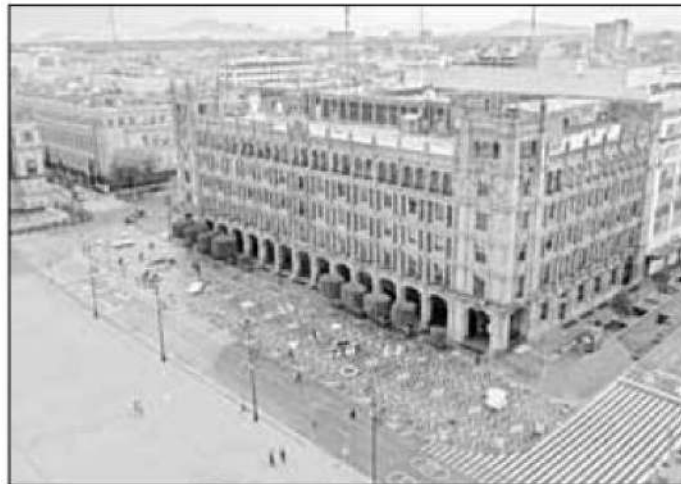
▲ La primera etapa del proyecto Zócalo Peatonal incluyó la reconfiguración de los carriles vehiculares de las partes sur y poniente de la Plaza de la Constitución. Foto Pablo Ramos
