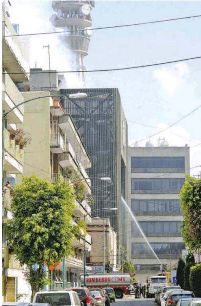
El inmueble ubicado en la calle Delicias que aloja la Subestación Eléctrica Buen Tono se incendió el pasado sábado 9 de enero /FOTO: JAIME LLERA
