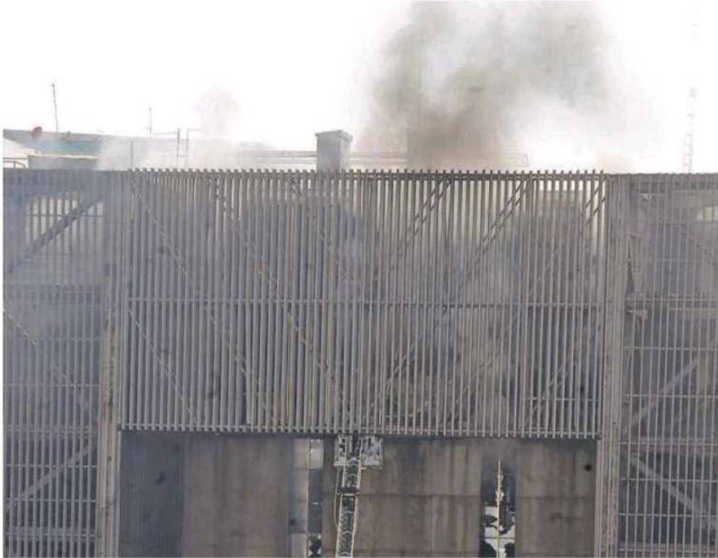
El siniestro en la Subestación Eléctrica del Metro dejó como saldo 30 personas lesionadas y una mujer policía fallecida /FOTO: JAIME LLERA
