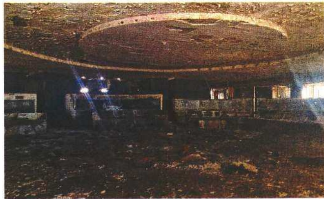
El 9 de enero, un incendio dañó el puesto de control del STC; siguen los peritajes.
