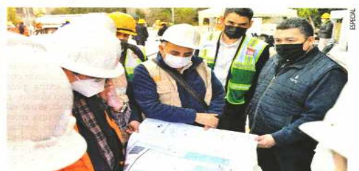
Elementos del Sistema de Transporte Colectivo continúan con los trabajos especiales para restablecer las redes con fallas.
