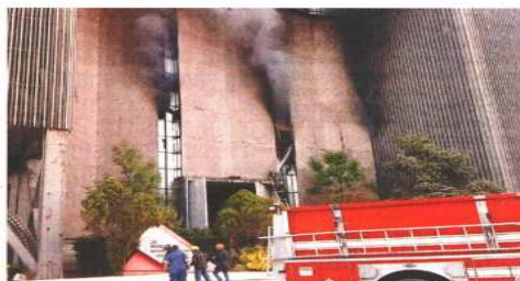
El sábado pasado se incendió la subestación eléctrica Buen Tono, lo que dejó fuera de funcionamiento seis líneas del STC Metro.
