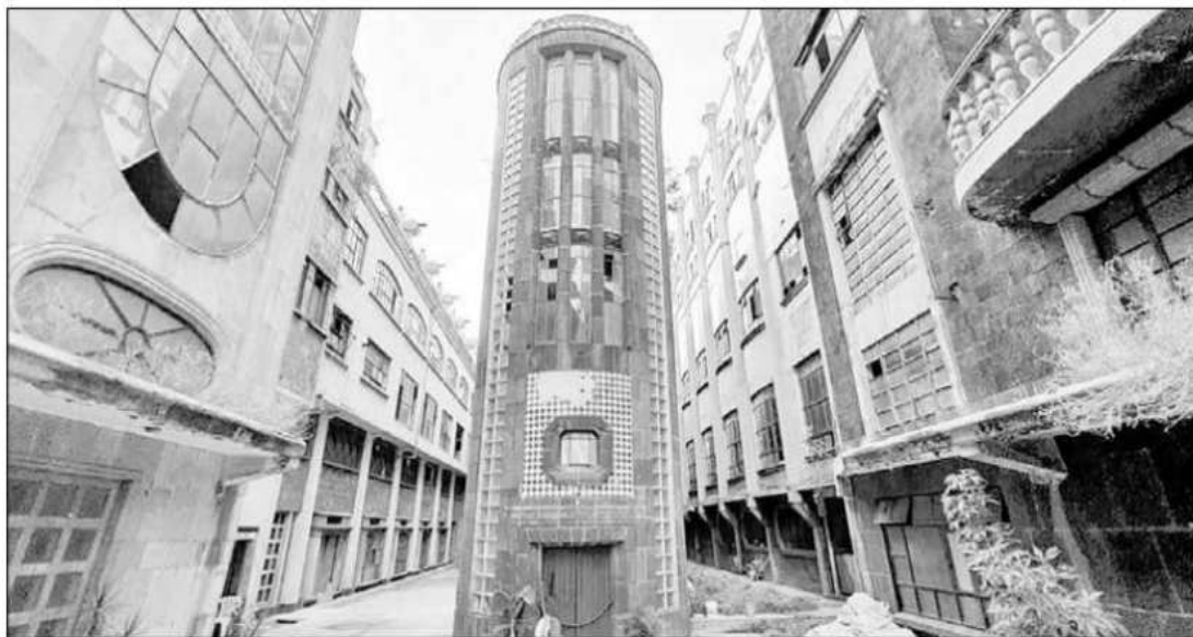
HOTEL LA POSADA DEL SOL
