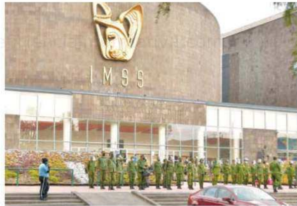
Por norma, todos los hospitales deben contar con un servicio eléctrico de emergencia por algún apagón /FOTO: DAVID DEOLARTE
