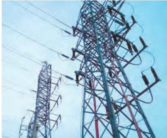
- Se activó la protección automatizada
