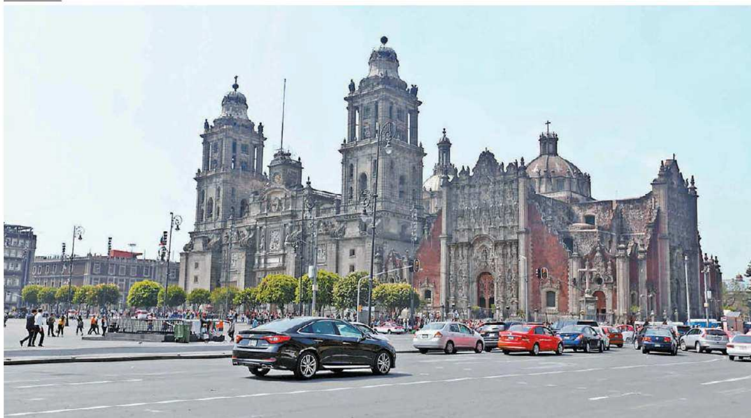
El objetivo es evitar incidentes como el de 1967, cuando el inmueble resultó dañado tras un corto circuito. ARACELI LÓPEZ
