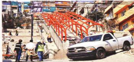
Sansores ofreció terminar la obra en la Colonia El Pirú este año. Así luce la escalera eléctrica a la fecha.
