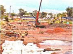
En septiembre se detuvieron las obras en el puente vehicular.
