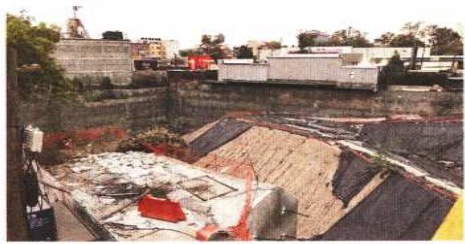
Los cimientos de las dos torres serán demolidos.
