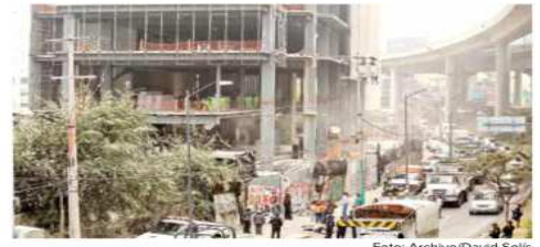
Cuatro pisos ya le fueron retirados al edificio de Periférico Sur 3042. Foto: Archivio/David Solís
