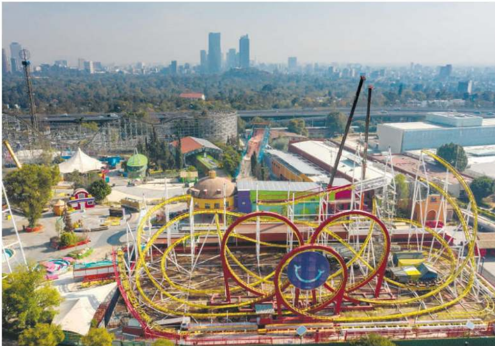
La montaña rusa que se encuentra en las instalaciones ya no es funcional, pero utilizarán parte de ella para rearmar algunos de los escenarios/ CUARTOSCURO
